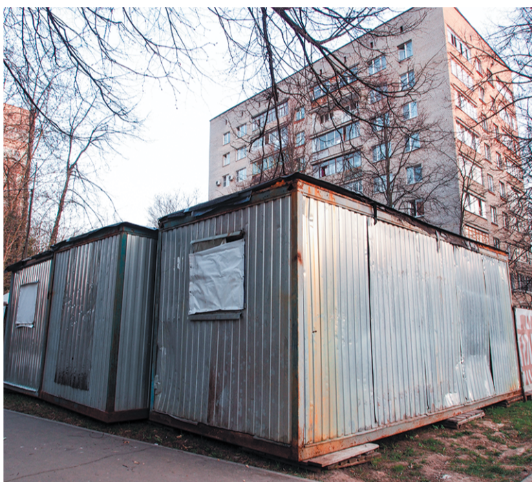
Бытовки у дома №9 на Школьной: верный признак капремонта
